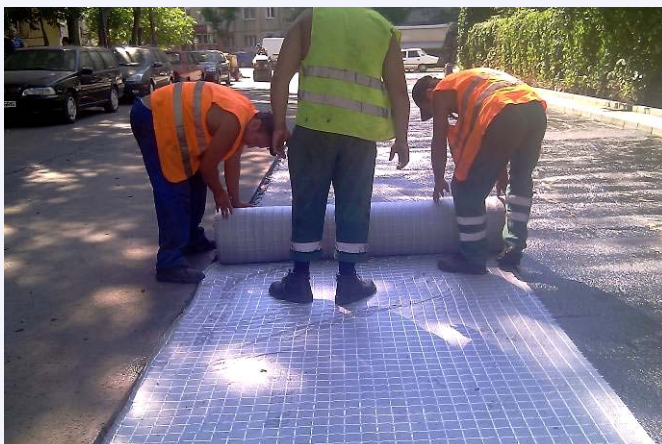
Instalarea geocompozitului antifisură
