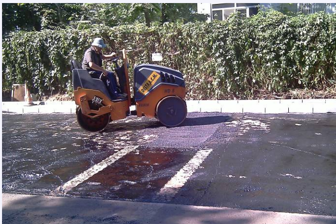
Umplerea găurilor cu mixtură asfaltică
