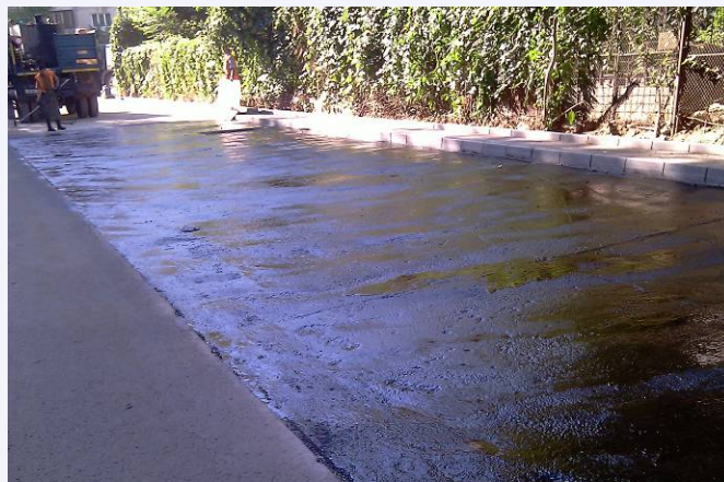
Împrăștierea emulsiei 0,6 litri pe metru pătrat
