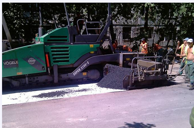
Instalarea stratului de asfalt
