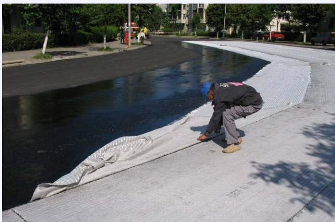
Rolele sunt instalate manual și sunt tăiate pentru punerea cap la cap cu următoarea rolă în curbă
