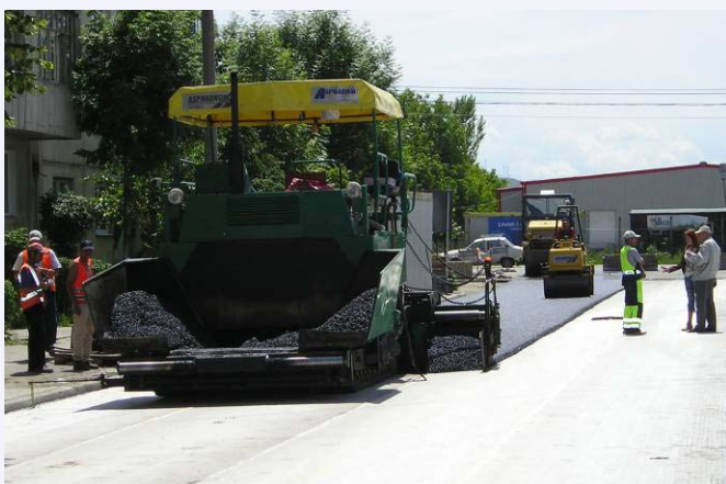
Turnarea noului strat de asfalt
