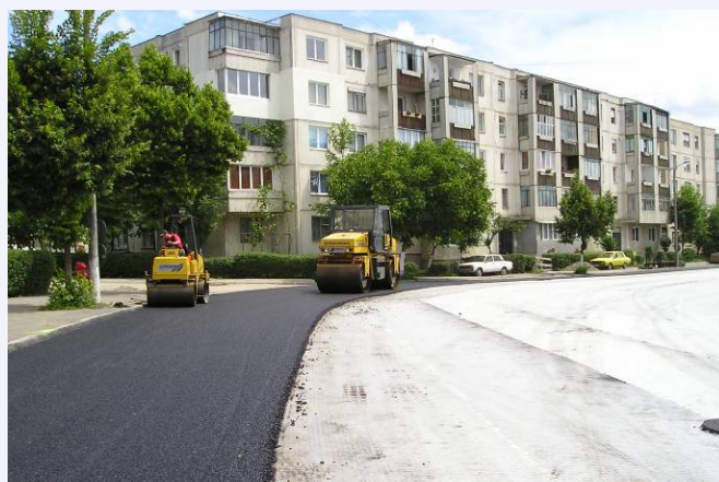
Compactrea stratului de rulare al străzii în curbă
