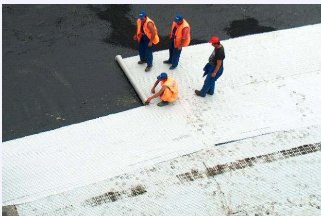
Instalarea materialului antifisură peste stratul de emulsie
