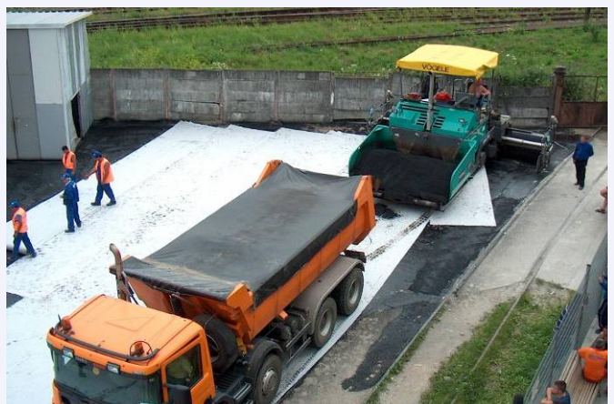
Instalarea noului strat de asfalt
