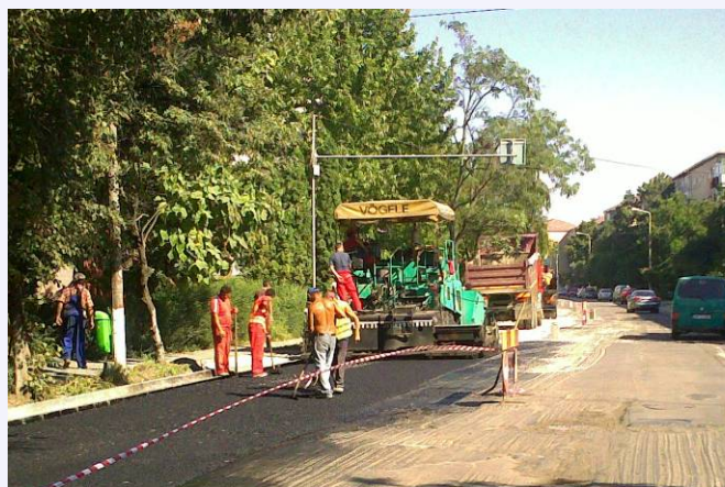
Instalarea stratului de egalizare
