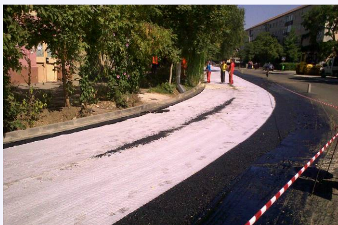
Instalarea materialului antifisură pe o curbă a drumului
