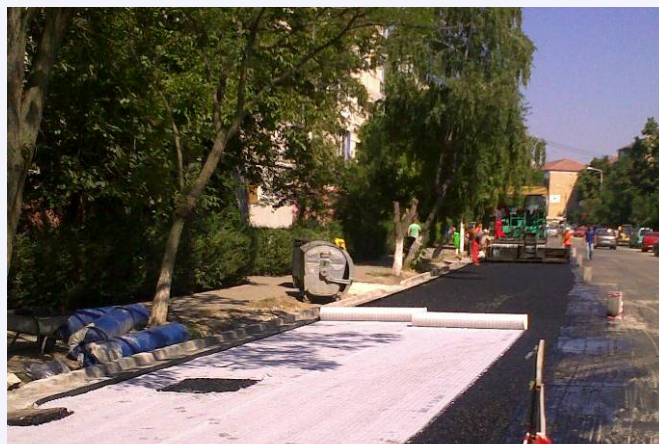
Instalarea geocompozitului antifisură
