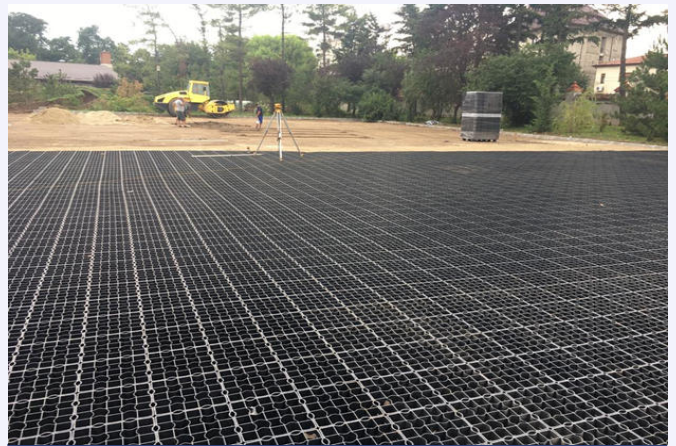
Umplere pavaje cu nisip si compactare
