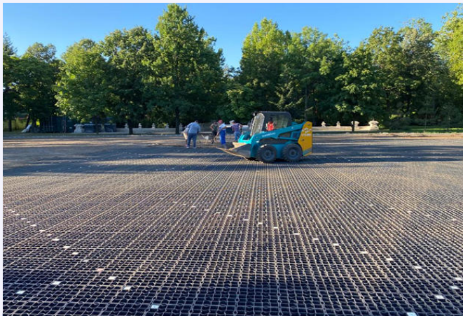
Umplere pavaje Ecoraster E50 cu nisip
