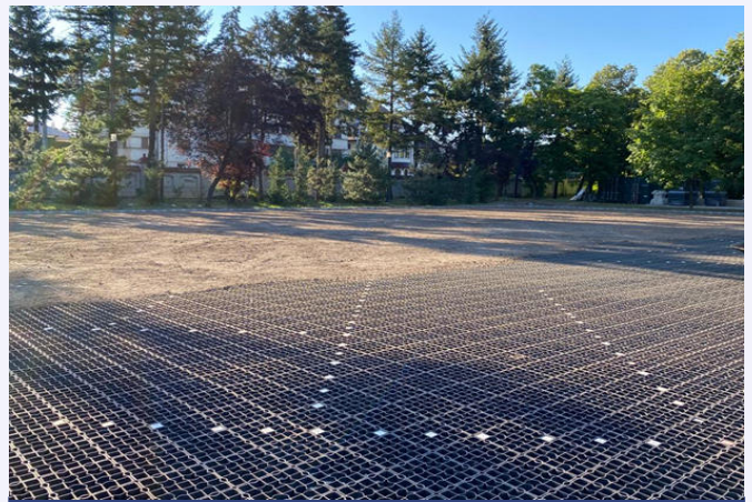
Umplere pavaje Ecoraster E50 cu nisip
